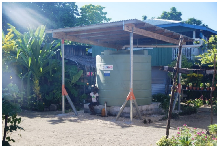
Figure 11. Rainwater storage tank on Kwai Island (J. van der Ploeg, 2017).
