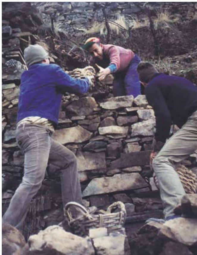
Conserver le paysage culturel nécessite une action et une attention constante dans le Parc National Cinque Terre, un Site du Patrimoine Mondial en Italie. © Luca Fregoso, 1992.
