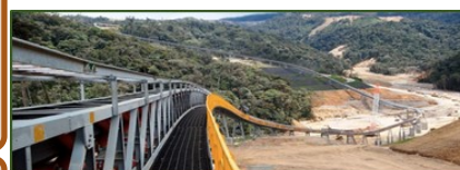
Infrastructure minière linéaire, Hidden Valley, Papouasie Nouvelle - Guinée . Image © Papua New Guinea Mine Watch
