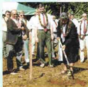
Le premier ministre du Samoa, Susuga Tuileapa Malielegaoi, lors de la cérémonie de retournement du sol marquant le démarrage officiel de la construction du siège du PROE
