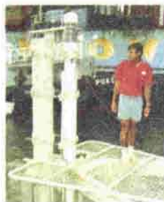
Inspection de seaframe, la station de surveillance du niveau de la mer et du climat. Port d'Apia, Samoa occidentales.
