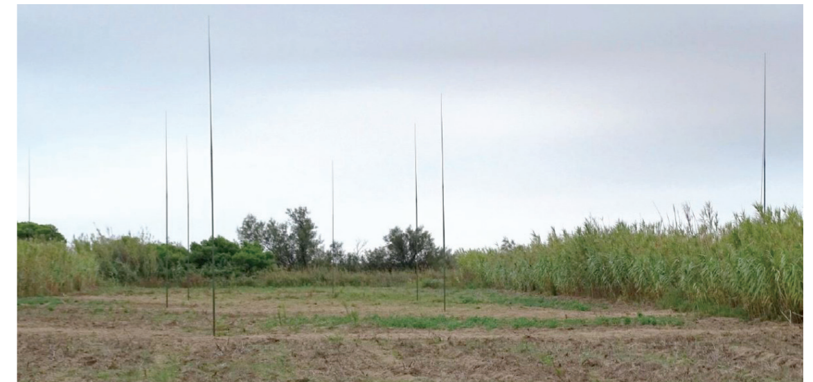
Figure 77 : Réseau d'antennes d'émission d'un radar HFSWR (© DigiNext).
