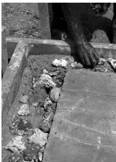
38. Kapsaedem kongkrit insaed long bes. Adem moa rok raon long slab, be bae oli no tajem timba.
