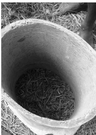
Rimuvum ol mold mo flat aean. Spos yu bildim wan drae toilet: Ademap 5 mm blong smen insaed long raesa. Smutum.
