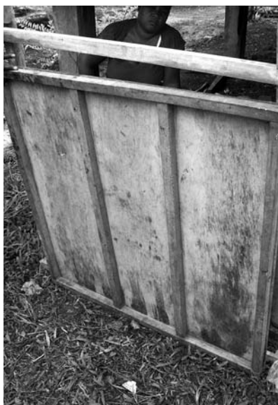
9. Floa slab: Konstraktem wan bes long plaewud mo frem blong floa slab
