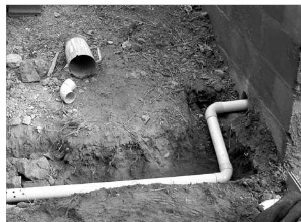
Drenpaep kasem ol sokej trench
