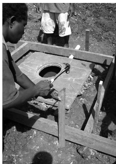
36. Instolem fomwok long sem haet wetem floa slab - livim wan spes blong 250 mm long ij saed blong slab.
