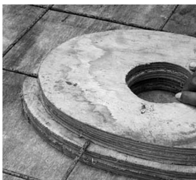
12. Mekem ol plaewud plang blong toelet hol: 2 bigwan mo 2 smolwan. Nelem ol smol wan tugeta. Plesem riba mesh waea we hemi rinfosem o yusum tae waea we yu twistim long 4.5 mm (3x1.5 mm) mo fasem long 100 mm spesing.
