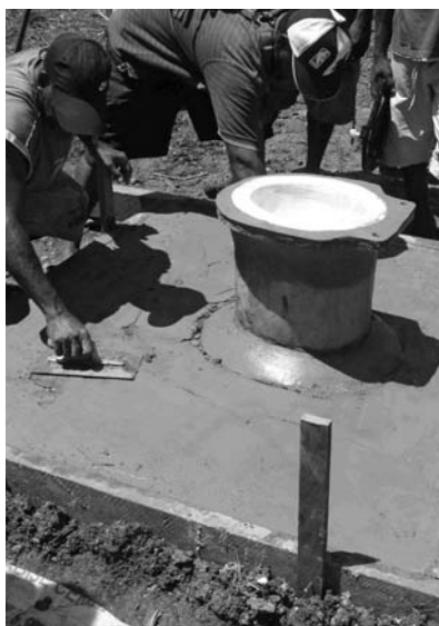
44. Smenem ova eni raf sefes blong floa slab. Smutum wetem wan pentbrash
