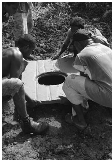
33. Karem slab igo long pit. Plesem apsaed daon antap long ol dram.
