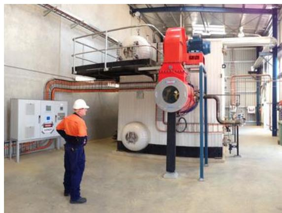
*Image : système de chaudière à vapeur avec récupération des émissions (Fidji)*
