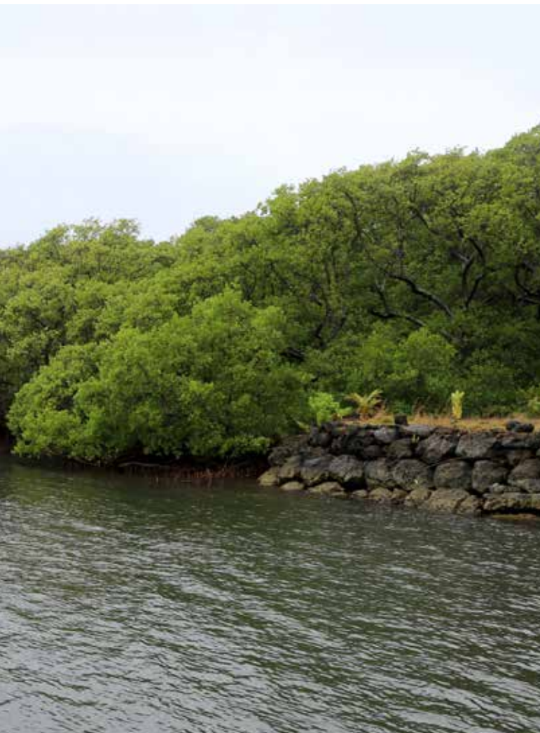
Méthode traditionnelle: Terre-plein gagné sur la mer intégrant une protection naturelle de la côte, Yap, ÉFM. Photo: Greg Barbara
